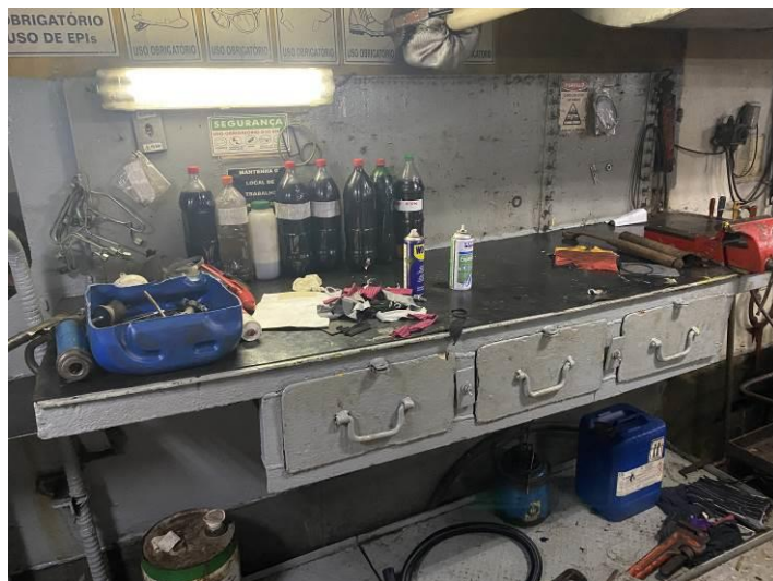
A foto ao lado mostra a bancada de ferramentas e trabalho.
