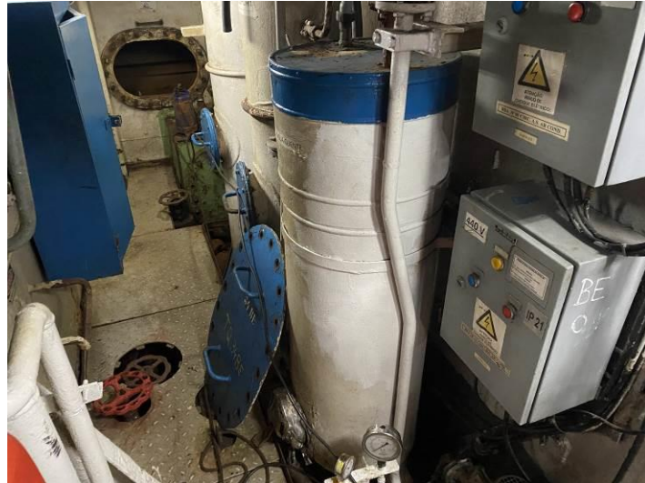
Aquecedor de água para acomodações 150 l/h.
